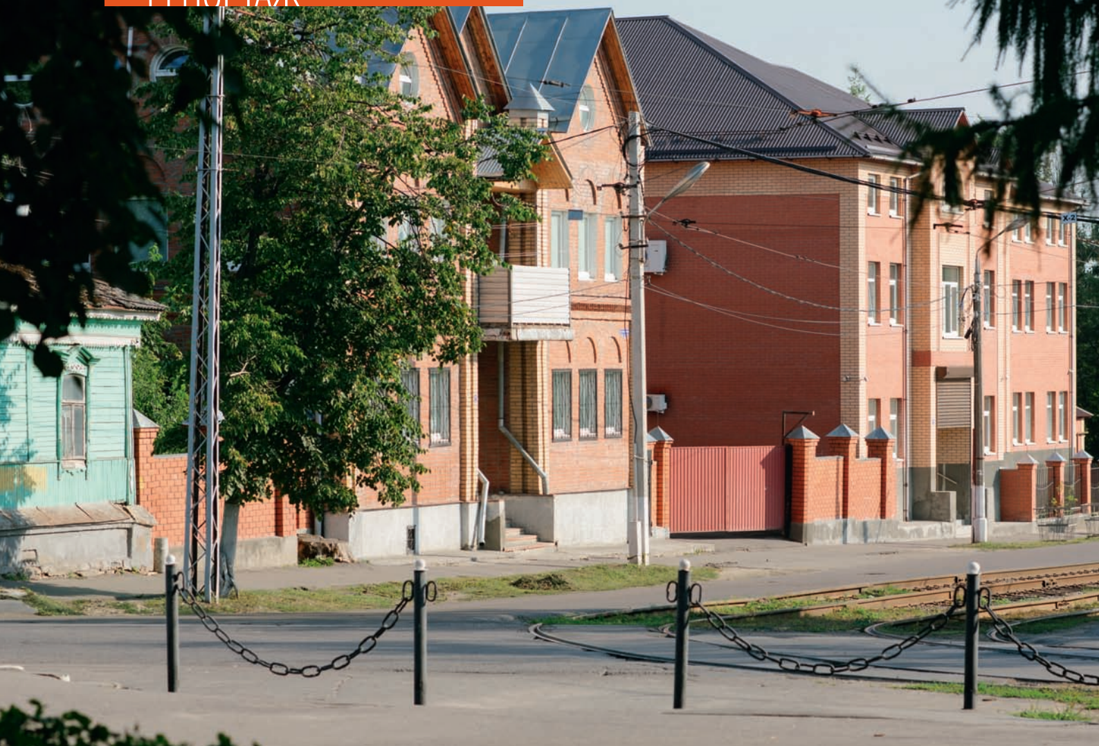
Центр разработки АСКОН в Коломне
