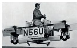
VZ-1 имел пару роторов противоположного вращения диаметром 1,5 м, расположенных внутри кольцевого канала. Каждый ротор управлялся собственным двухтактным двигателем мощностью 40 л. с. Пилот стоял над
